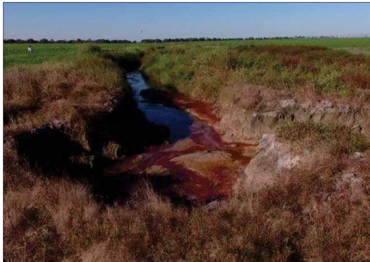
Figura 2: Erosão em afluente do Rio Araguaia. Fonte: Google, 2019.
